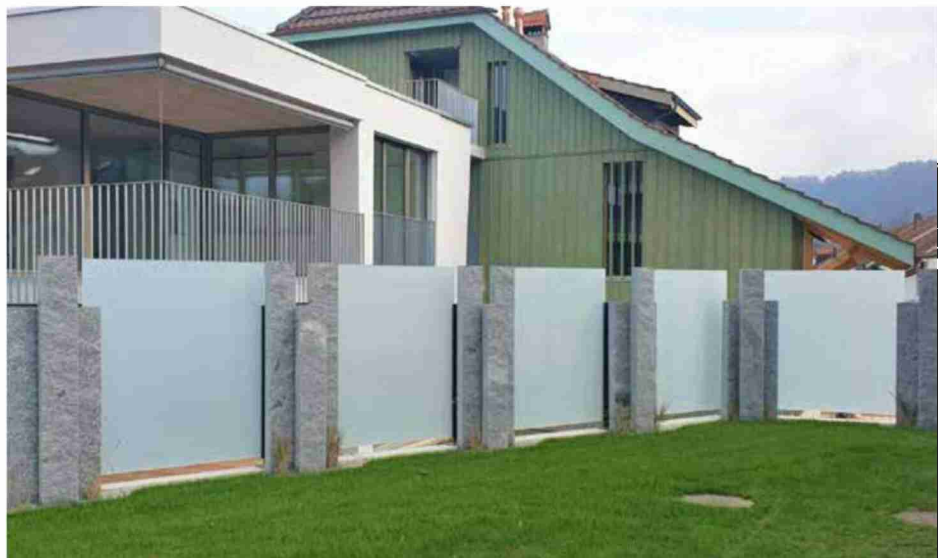
Sichtschutz-Zaun auf einer Mauerkrone im Auftrag des Gartenbauunternehmens Graf Grün
